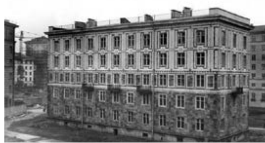
Рис. 18. Первый бескаркасный крупнопанельный дом, построенный в Ленинграде (на улице Полярников, 10) в 1955 году трестом № 3. Архитектор А. В. Васильев, инженер З. В. Капунов
