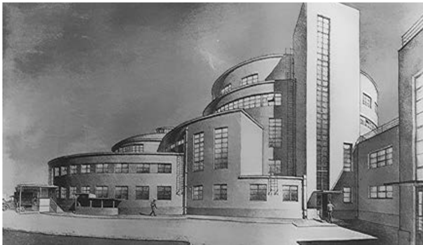
Рис. 7. Кушелевский хлебозавод, 1933. Архитектор А. С. Никольский, инженер Г. П. Марсаков
